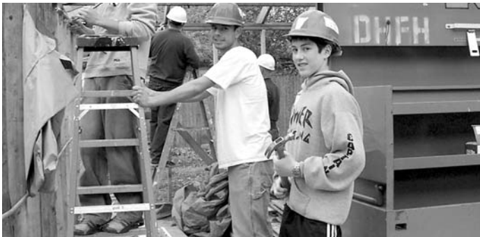
HÁZÉPÍTÉS A HABITAT FOR HUMANITY SZERVEZÉSÉBEN
